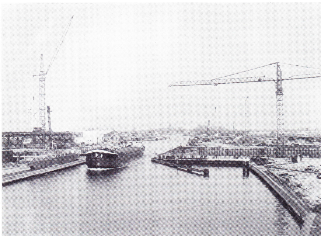
De scheepvaart ondervond betrekkelijk weinig hinder tijdens de bouw van het aquaduct. (Foto: G.A. van Leeuwen)
